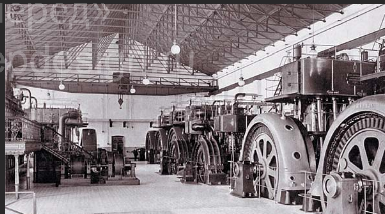
Вверху: исторический вид машинного зала.
